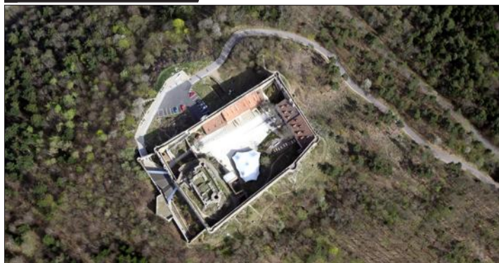
Le château du Hohlandsbourg, sa large esplanade et son chemin de ronde.
